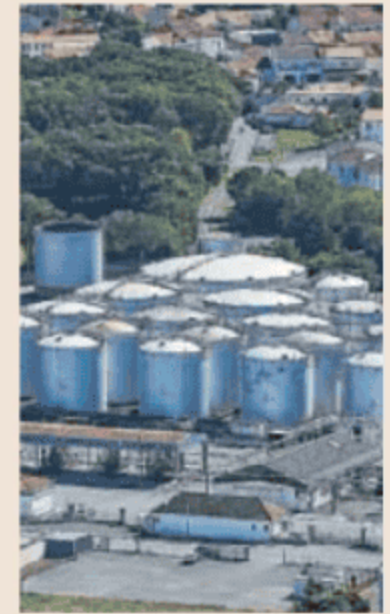
Tanques para almacenar petróleo en La Rochelle (Francia). GETTY IMAGES
